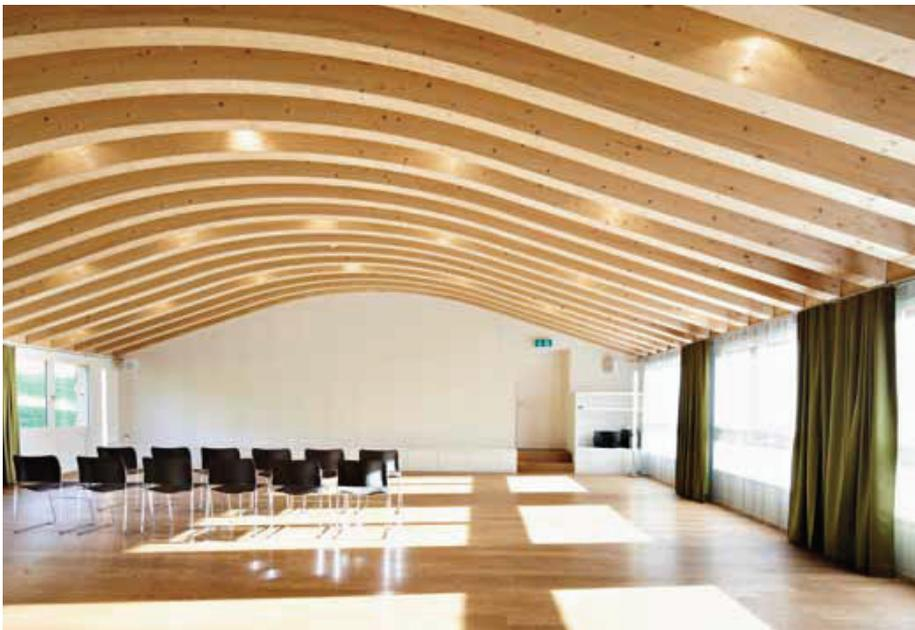
Dank der neuen Deckenkonstruktion aus Brettschichtholz-Bogenbindern erhält der Saal im Zwischenbau einen höheren Kniestock, was die Raumqualitäten um ein Vielfaches verbessert (oben). Auch der Firstsaal im Gassahaus wurde ausgeräumt (rechts oben). Erhalten blieben die schönen Schlafzimmer im alten Walserhaus (rechts).
